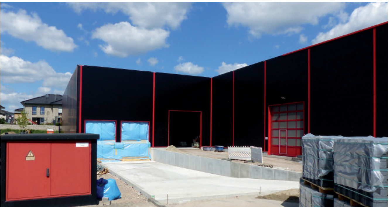
Anbau des Produktionsgebäudes in der Artegastraße im Sommer 2016 (Erweiterung der Produktions- und Lagerflächen für die Segmente Elektromobilität und Mechanik)
